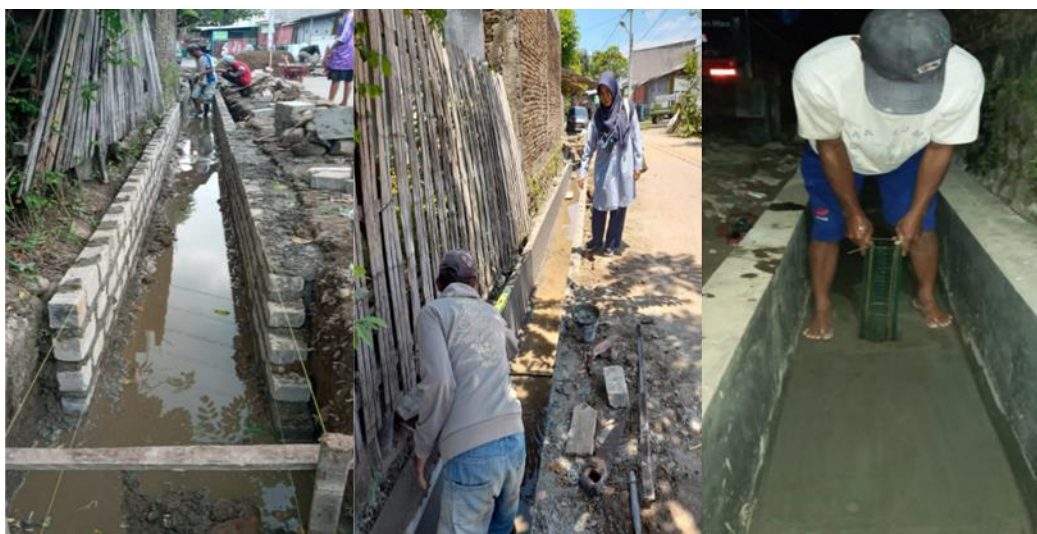
Gambar 5. Pekerjaan saluran untuk pemasangan silinder berpori
