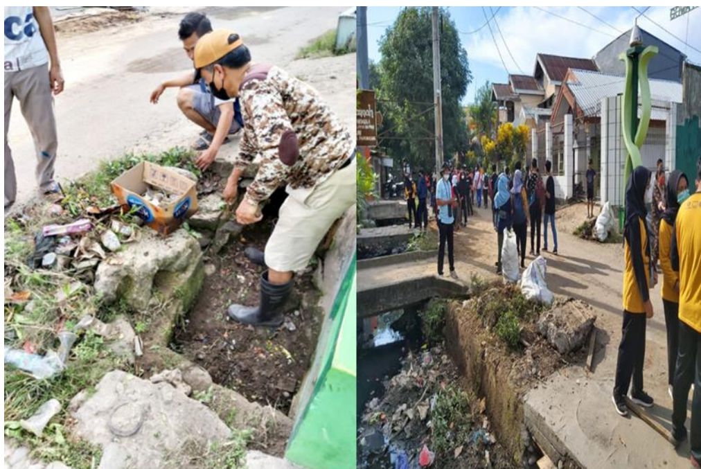
Gambar 2. Pengangkatan sampah di saluran drainase
