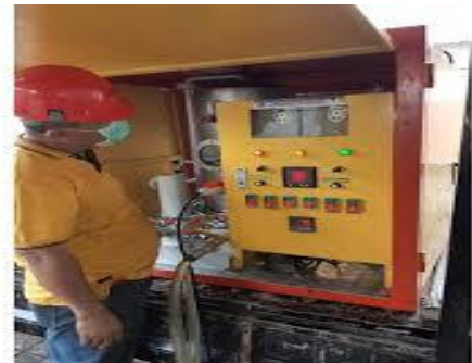
Gambar 4.1 Pengisian Minyak Transformator saat ON setelah dipurifikasi
