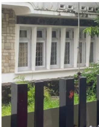
Gambar 16. Tampak Susunan Jendela pada Area Exterior
