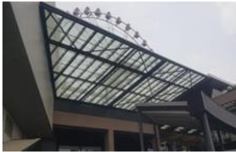
Gambar 16. Kanopi dan sun shading di AEON Mall Jakarta Garden City Sumber: Pribadi, 2019
