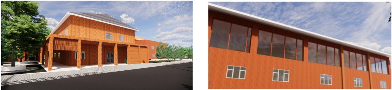
GAMBAR 5. Kaca Tempered dan Wall Panel
