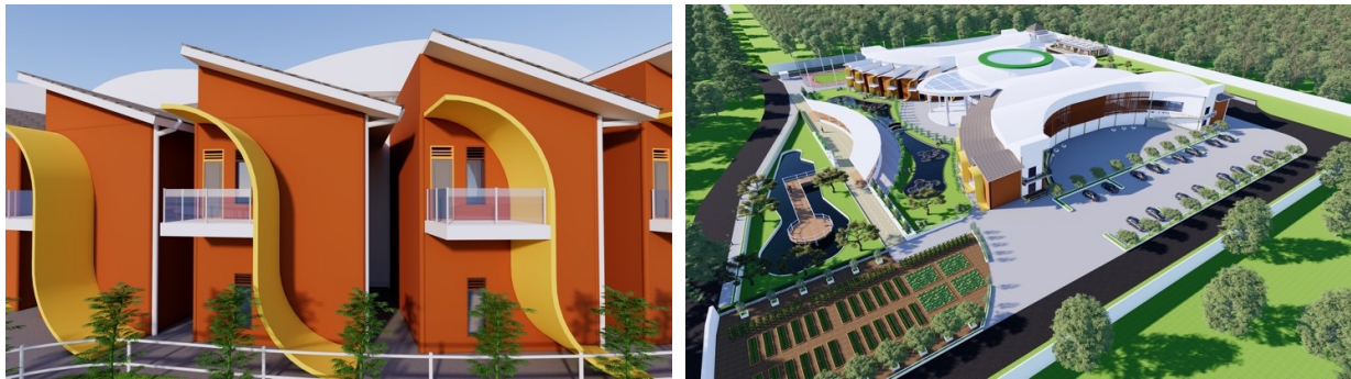
GAMBAR 4 Atap dan Struktur Atap Bangunan
