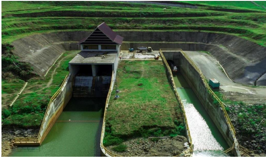
Gambar 5. Foto dokumentasi saluran pengeluaran Bendungan Paselloreng
