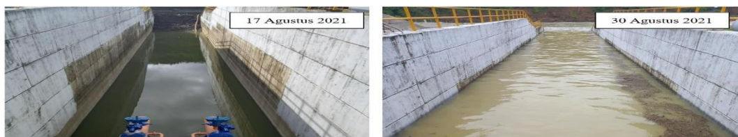
Gambar 7. Foto dokumentasi bagian hilir bottom outlet
