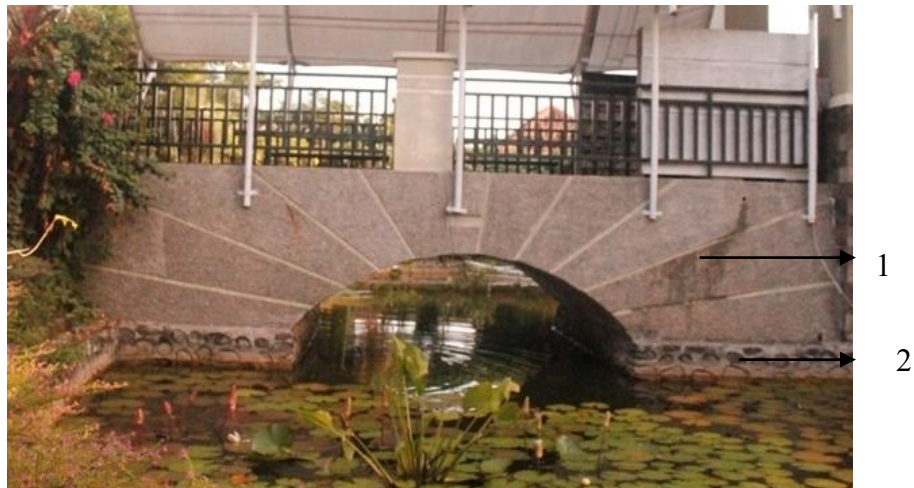
Gambar 8. Jembatan disisi Kanan (Dokumentasi Nurzakiah, 29 Juni 2014)
