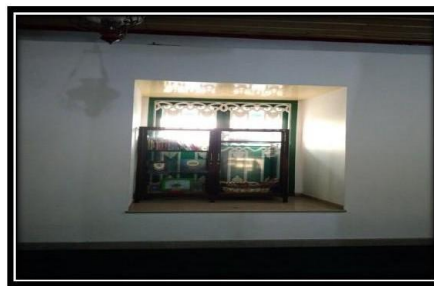
Gambar 9. Ketebalan Dinding Masjid Katangka Sumber: Dokumentasi peneliti
