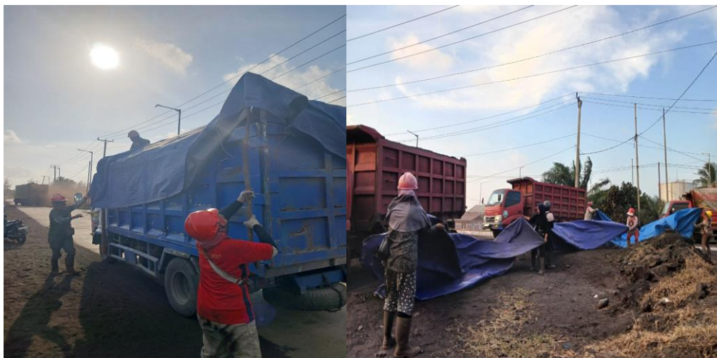
Gambar 1 proses pembukaan terpal dari truk pengangkut batubara
